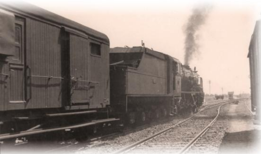
Enlace en Calahorra con la línea principal de ferrocarril del Norte Fotografía de Christian Schnabel.
