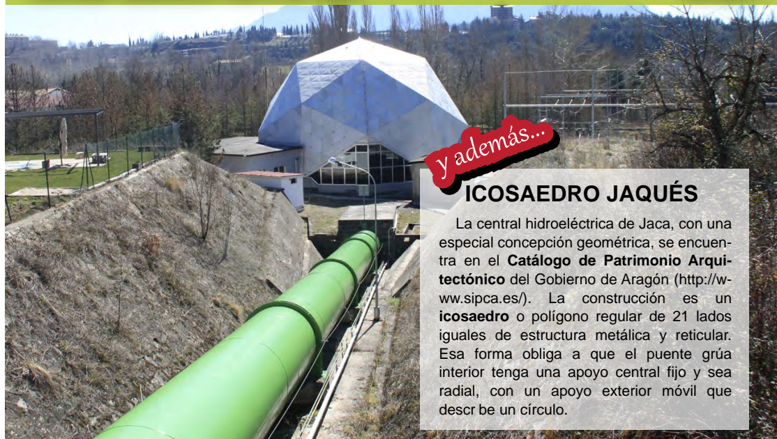
Central hidroeléctrica de Jaca. Foto: J M. Samsó
